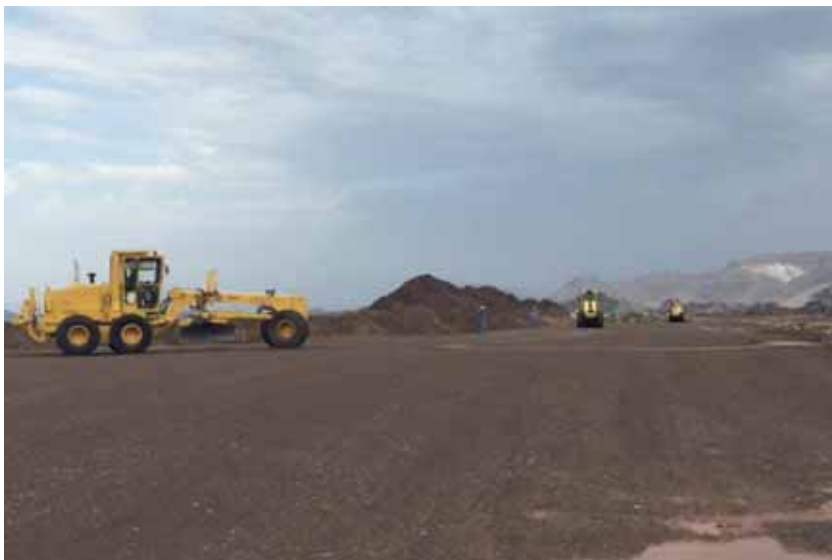
■ آليات ومعدات تباشر عملها خلال بدء المرحلة الثانية من مشروع ازدواجية طريق (عبري - ينقل) بمحافظة الظاهرة
