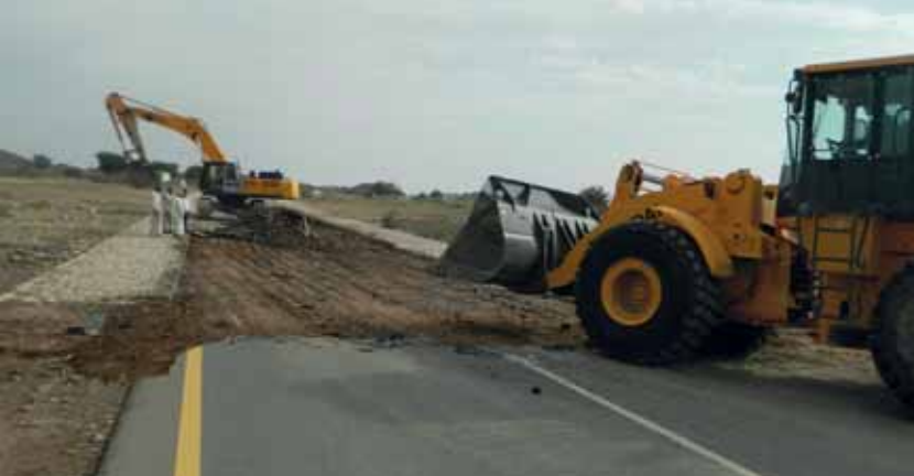
■ إزالة الطبقات الإسفلتية المتعرجة بالطريق
