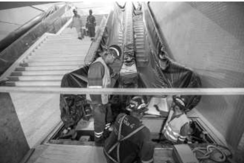
■ عمال برازيليون يباشرون عملهم داخل أحد مواقع البناء التي تستضيف الألعاب الاولمبية وذلك في ريو دي جانيرو.
