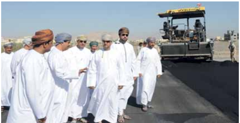
■ ...وخلال متابعته أعمال رصف الطرق الداخلية بولاية منح
