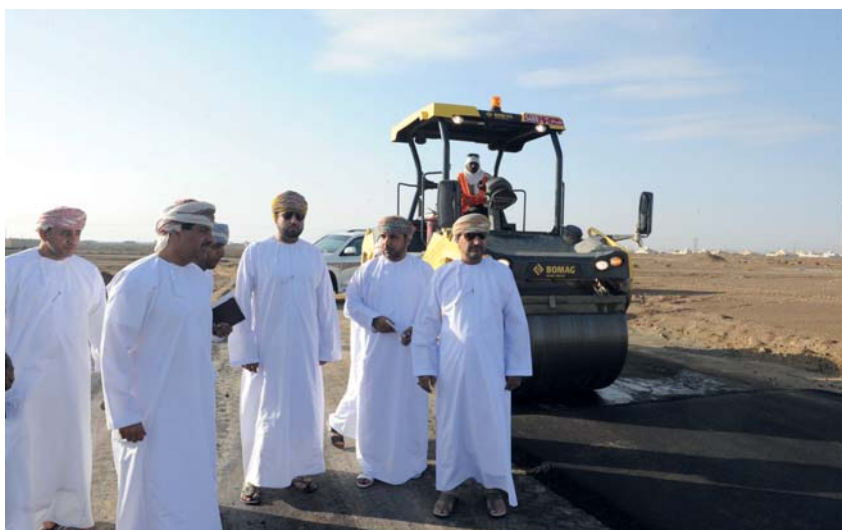
■ وزير البلديات خلال متابعة تنفيذ أعمال رصف الطرق الداخلية بالبريمي من المصدر
