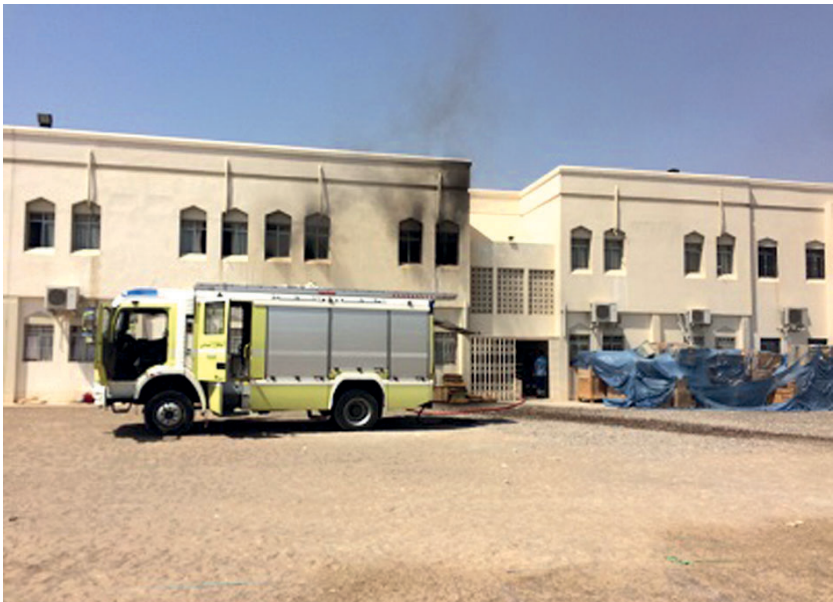
■ إحدى مركبات الدفاع المدني تطفئ الحريق
