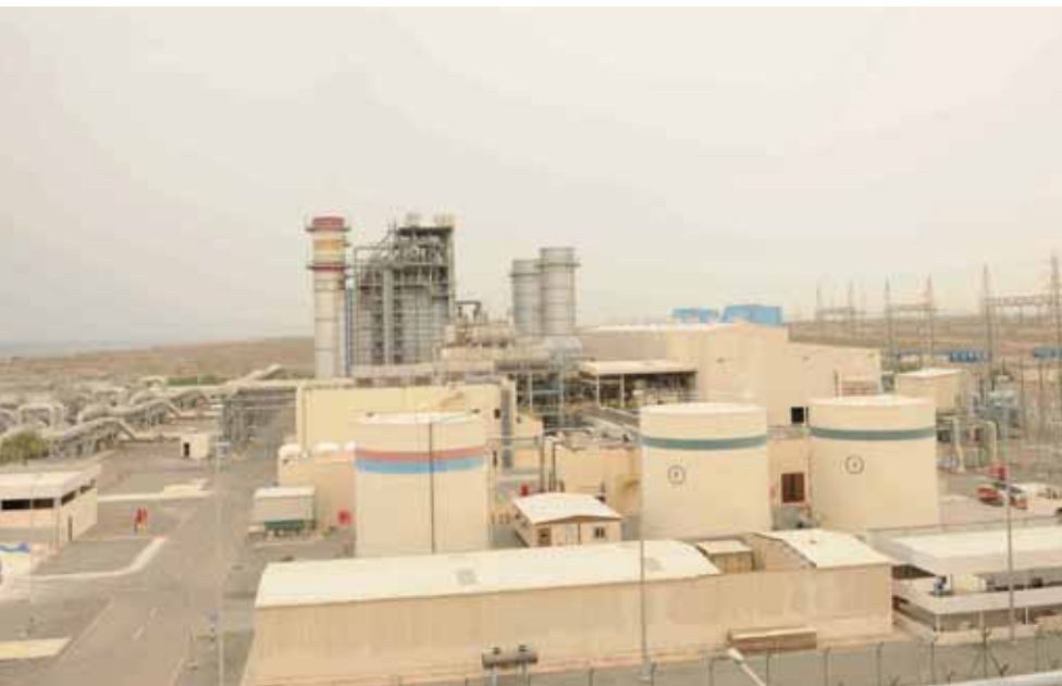
■ محطة تحلية المياه بصحار
