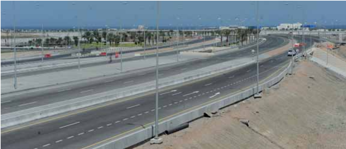
■ شبكة طرق حديثة تم افتتاحها بمشروع طريق مطار مسقط الدولي «من المصدر»
