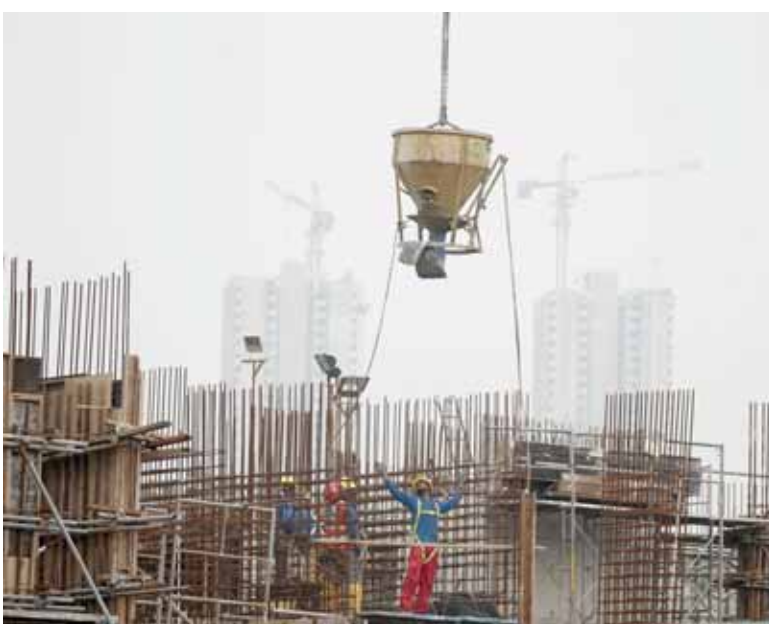
■ عمال بناء يستعدون لتفريغ خرسانة في موقع بناء في ستغافورة أمس في الوقت الذي تكاد تغطي فيه سحب الضباب القادمة من اندونيسيا المجاورة السماء حولهم.
