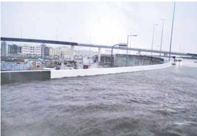
■ الصورة التي تم تداولها للجسر قيد الانشاء
