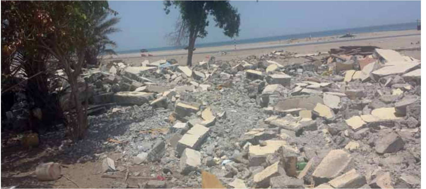
■ من مخلفات البناء للمنازل التي تم هدمها لتنفيذ مشروع طريق الباطنة الساحلي
