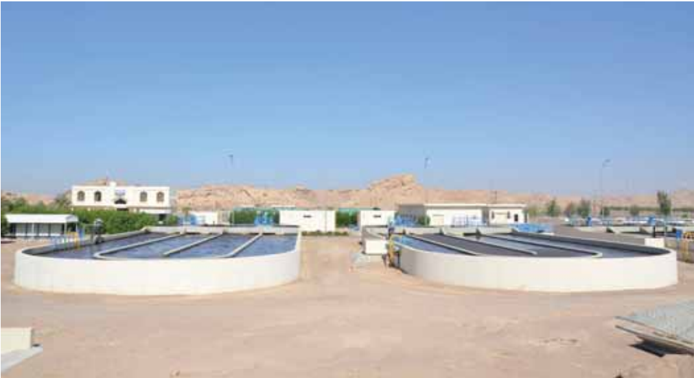
■ احدى محطات الصرف الصحي التي سيتم ادارتها من قبل «حيا للمياه»
