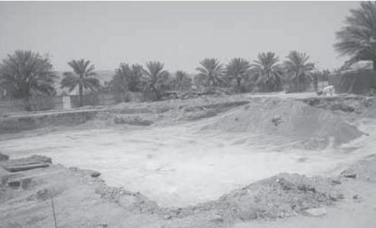
أعمال الحفر لمشروع وحدة الكلى في عبري
