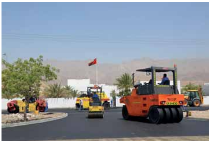
■ من مشاريع رصف الطرق
