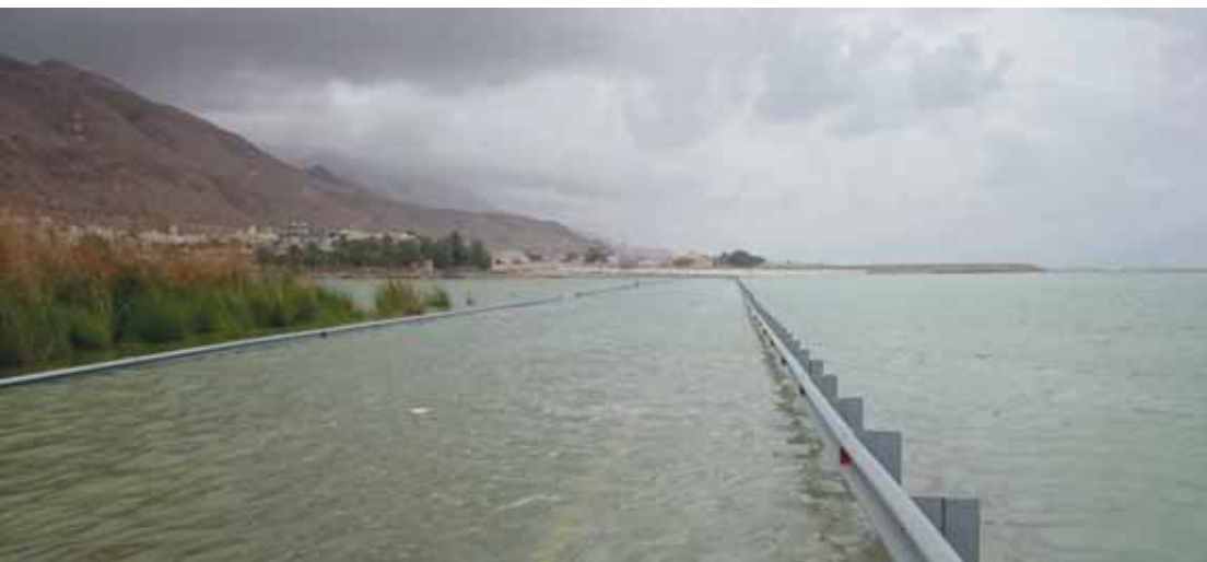
■ دخول مياه البحر في شوارع طيوي الداخلية و تغلقها
