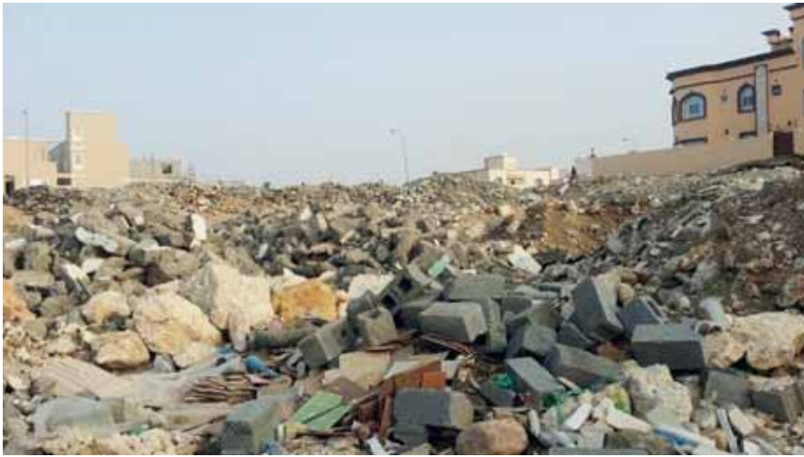
■ البعض يستخدم المخلفات لردم الاساسات فتتسبب في تصدعات في المباني
