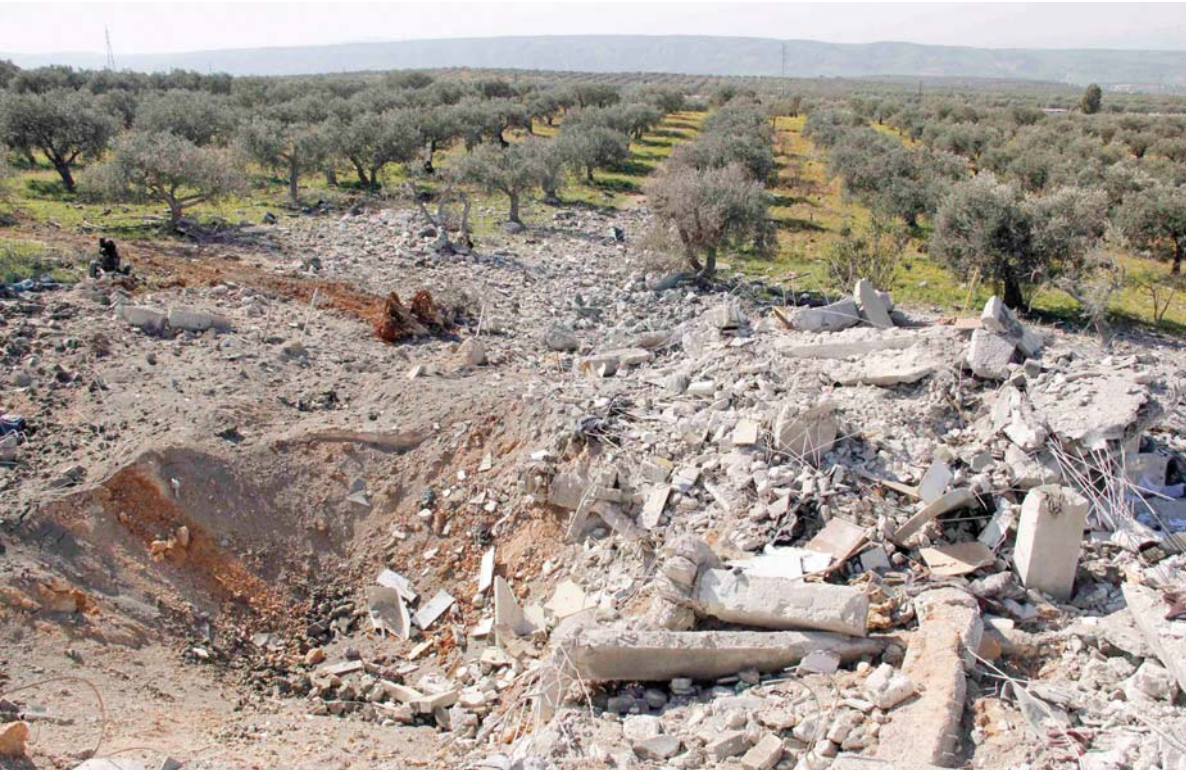
■ حمام منزل تابع لجبهة النصرة والذي تم تدميره في قصف للجيش السوري في إدلب أمس
