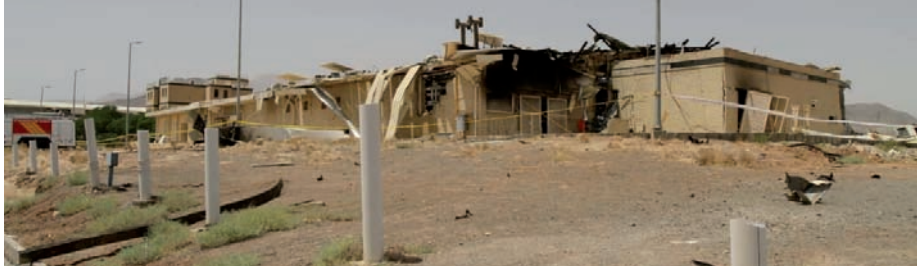
■ منظر للآضرار التي لحقت بمبنى تابع لمشأة نطنز النووية الإيرانية، جنوب طهران. (أ ف ب)
