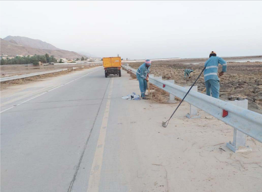
■ ضمن أعمال تنظيف الطرق بوادي طيوى
