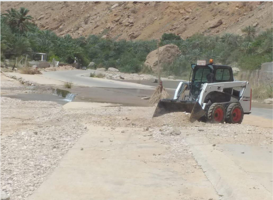
■ أعمال فتح الطرق بوادی طیوی
