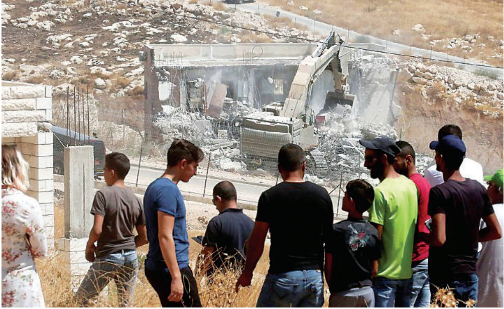
■ هدم منشآت في وادي الحمص جنوب القدس
