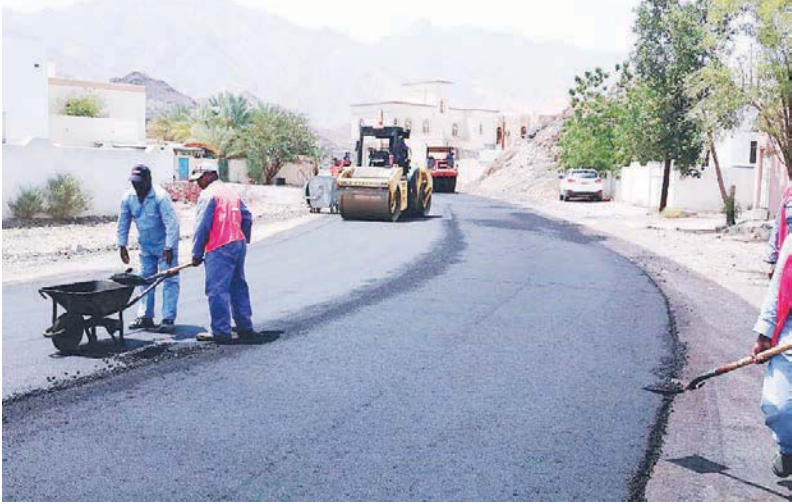
■ من أعمال رصف الطرق الداخلية بولاية سمائل
