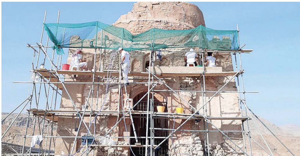
■ جانب من أعمال الترميم
