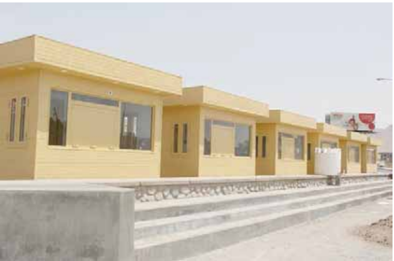
■ أعمال الصيانة التي تم الانتهاء منها للسوق
