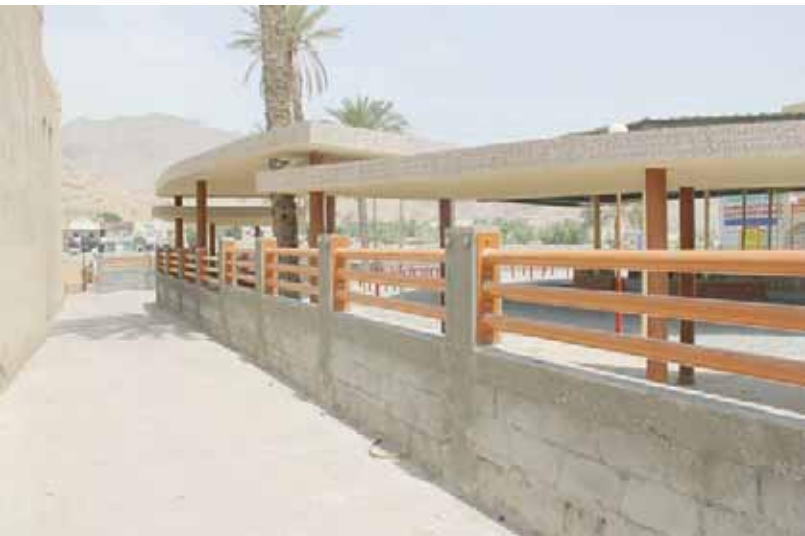
■ جانب من أعمال الصيانة
