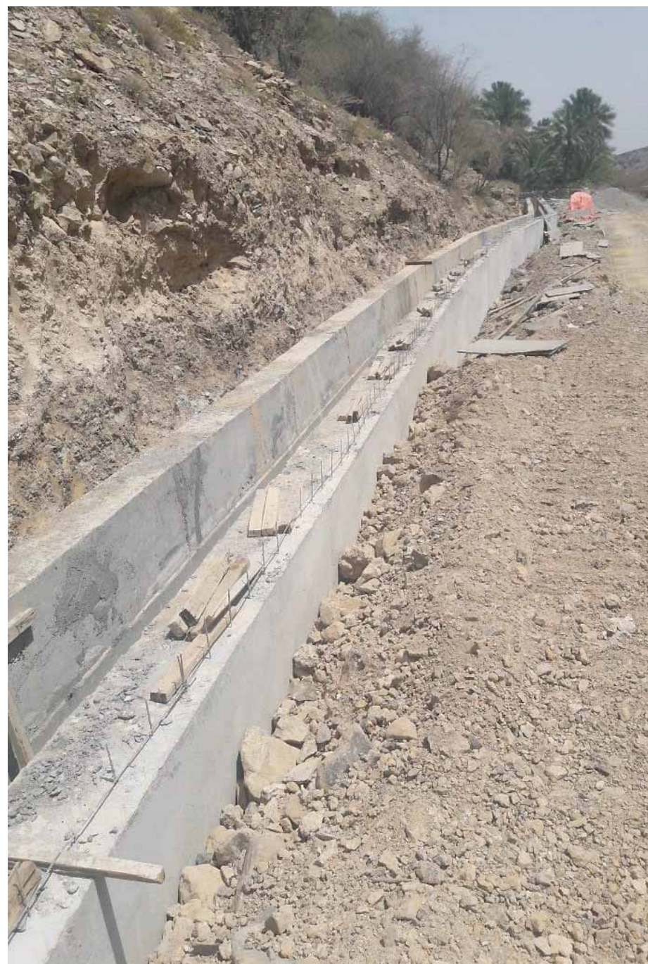
■ تنفيذ أعمال الصيانة للأفلاج
