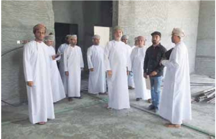
■ أثناء الاطلاع على المباني قيد الإنشاء
