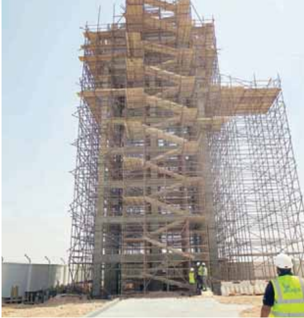
■ خزان المياه العلوي في العجائر بسعة ٢٠٠ متر مربع
