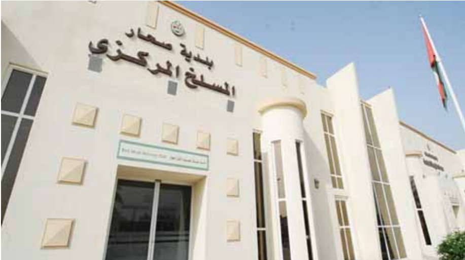
■ مبنى المسلخ المركزي بصحار
