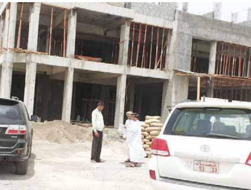
■ جانب من متابعة المنشآت والمباني ومدى تقيدها بالاشتراطات
