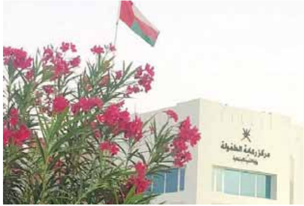
■ مبنى مركز رعاية الطفولة بالخوض
