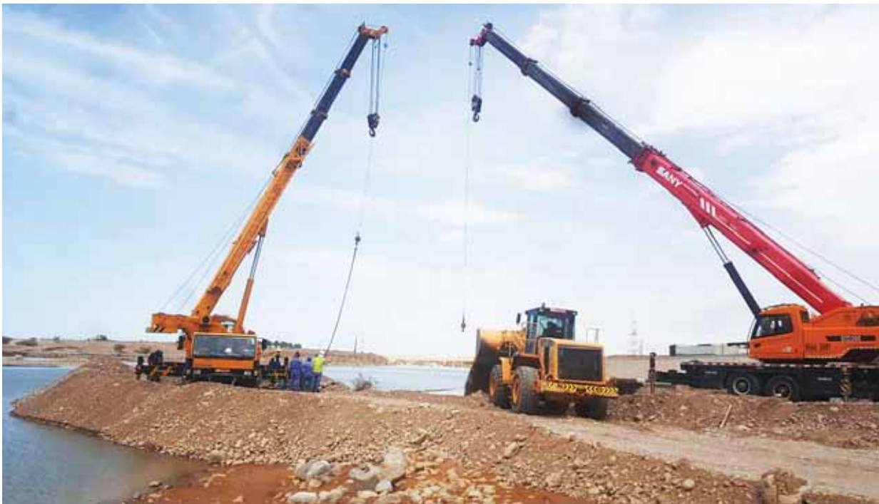
■ تنفيذ عدد من أعمال الكشف والإصلاح لأنابيب المياه
