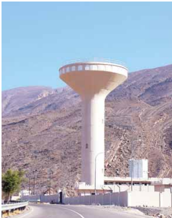
■ من خزانات المياه
