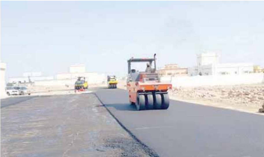
رصف الطرق بالمحافظة
