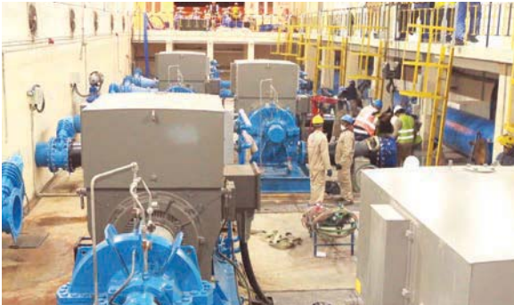
أثناء تنفيذ عملية الربط لمشاريع المياه الجديدة
