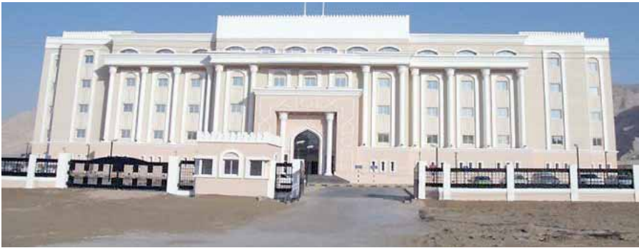
■ مبنى الكلية الحديثة
