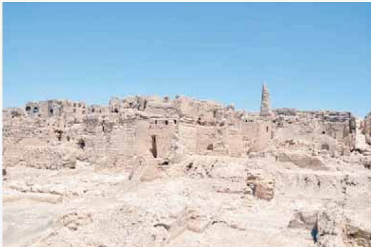
■ تهدم البيوت الداخلية بحصن السليف
