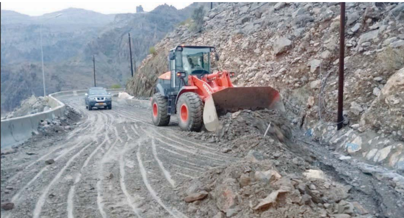
■ جانب من أعمال إعادة فتح الطريق - الجبل الأخضر
