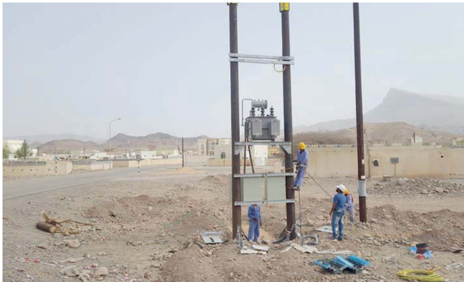
■ من أعمال تعزيز خدمات الكهرباء
