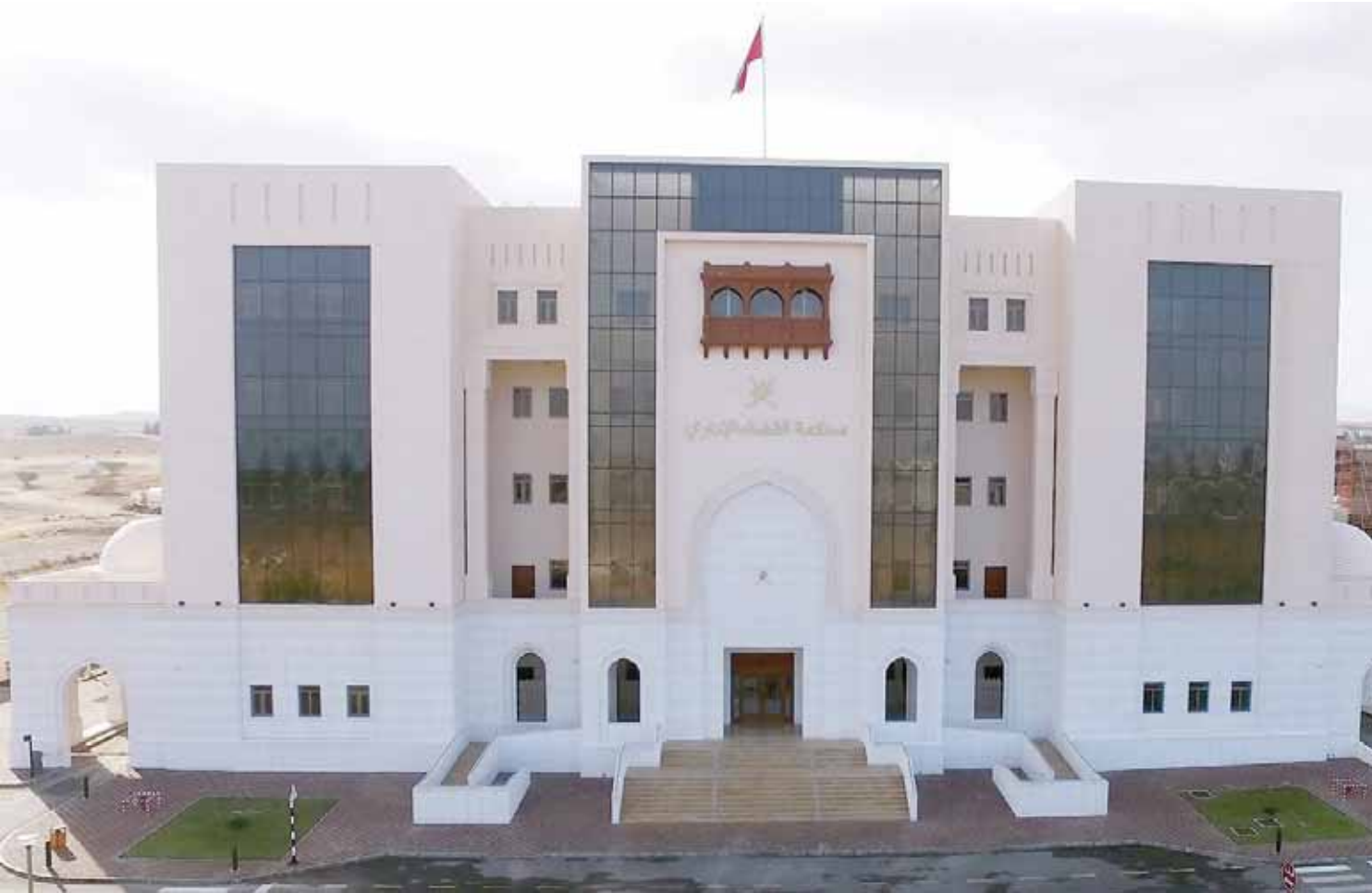
■ مبنى محكمة القضاء الإداري الجديد
