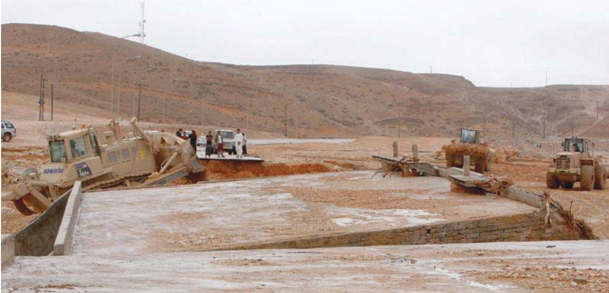
■ جهود الخدمات الهندسية لإصلاح الأضرار
