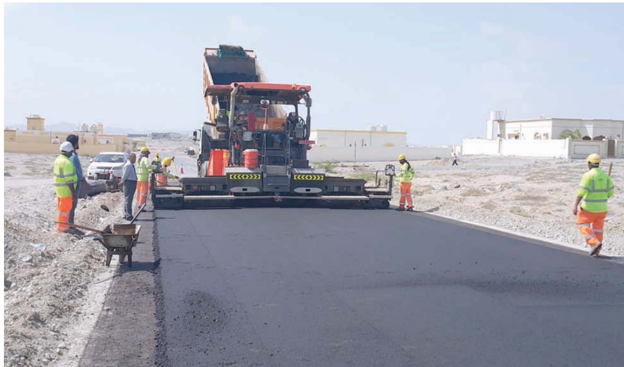
■ من أعمال رصف الطرق
