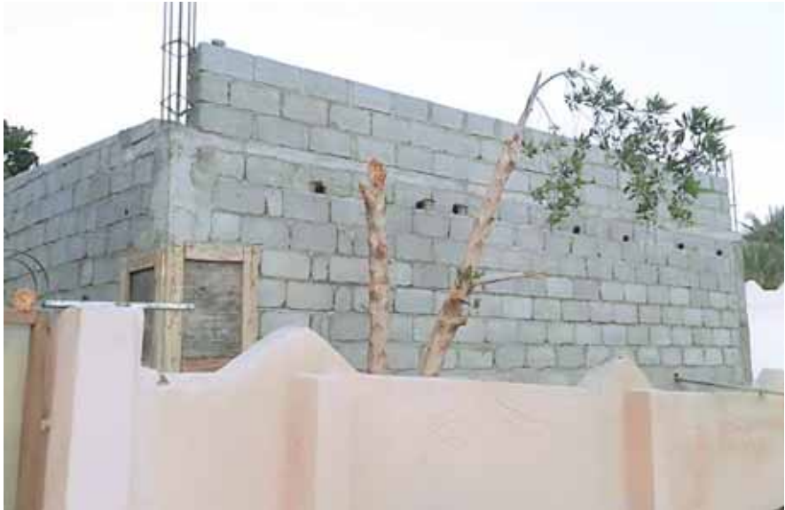
■ من أعمال الترميم
