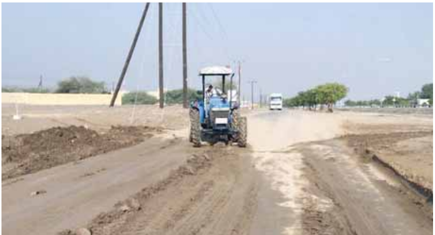
■ من أعمال إزالة وفتح الطرق
