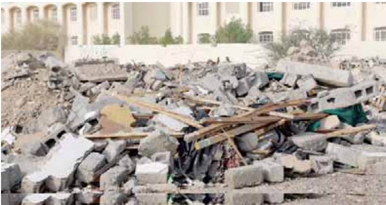
■ تراكم مخلفات البناء بجانب الأحياء السكنية
