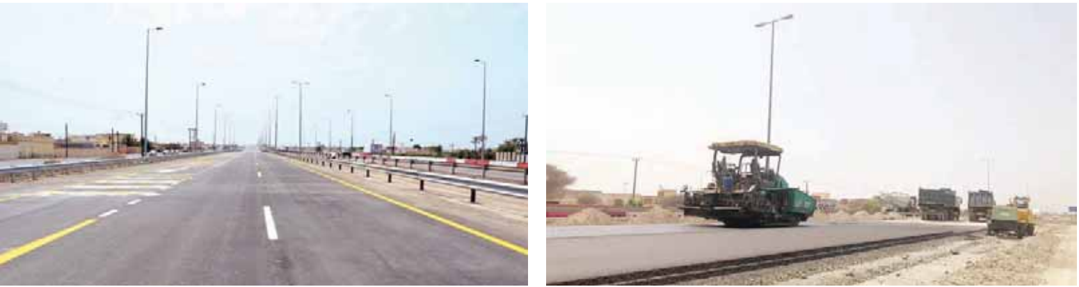
■ جانب من رصف الطرق
