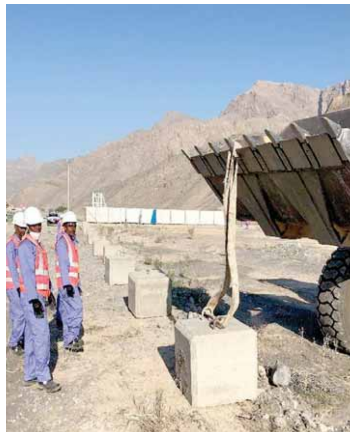
■ بدء الأعمال الإنشائية لبناء مستشفى خصب
