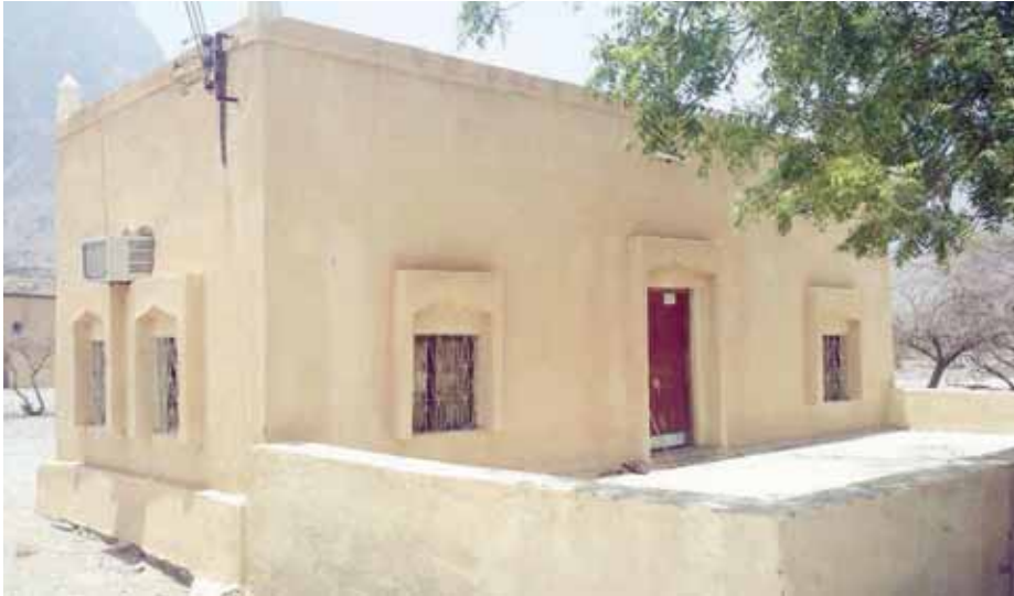
■ مسجد السيد فيصل بقرية الحيل بعد إعادة البناء
