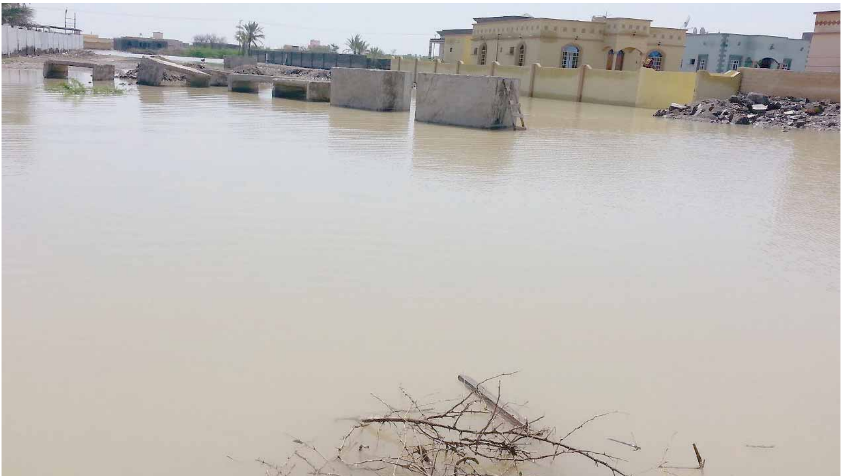
■ بقايا مياه الأمطار تمكث لفترات طويلة في المخططات التعويضية
