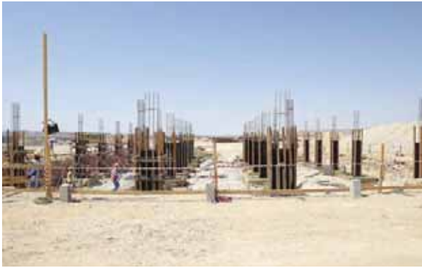
من أعمال الإنشاءات
