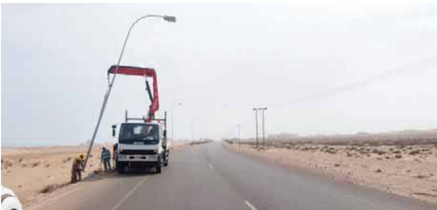
■ من أعمال التركيب
