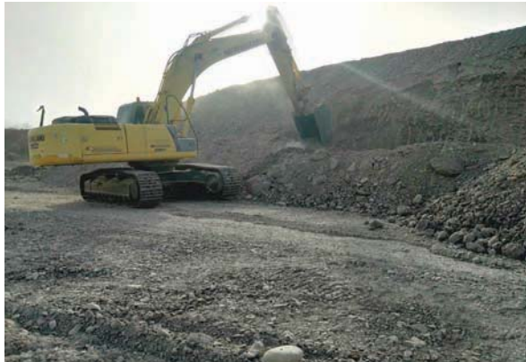
من أعمال رصف الطريق
