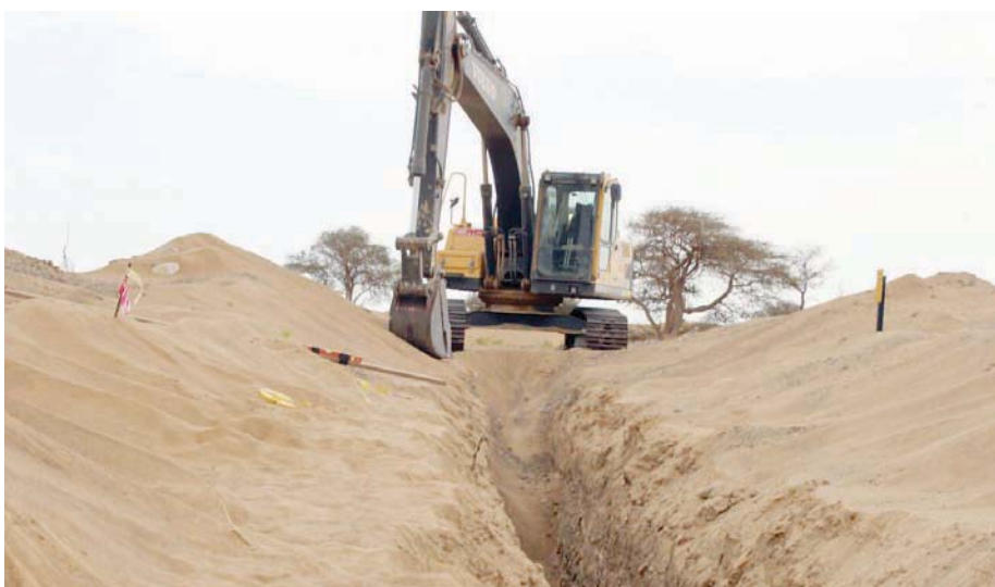
■ خلال أعمال توصيل المياه
