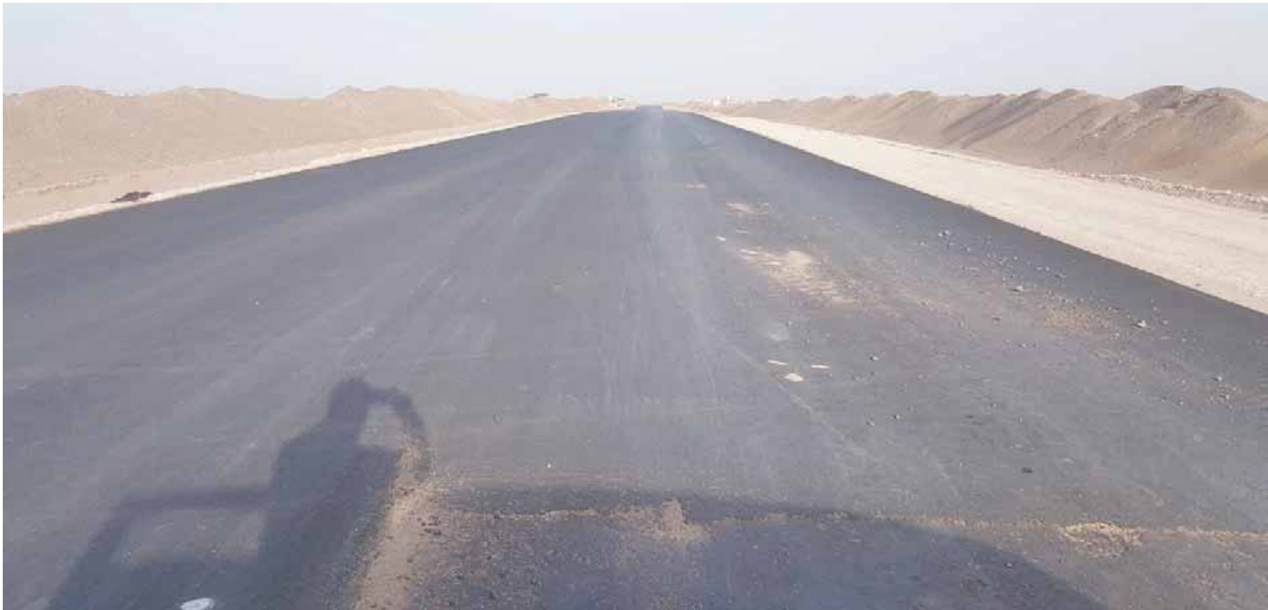
■ من أعمال رصف الطرق المؤدية إلى الشركة
