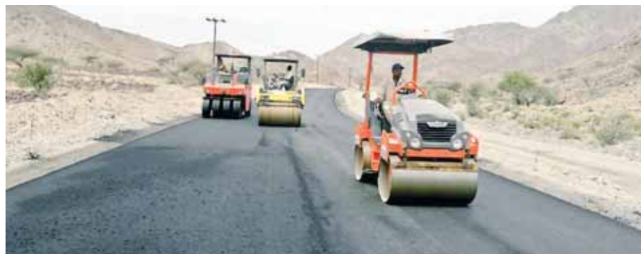
■ جانب من رصف الطرق الداخلية بمحافظة الظاهرة
